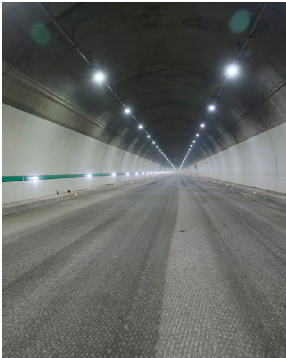
Base tunnel on the Variante di Valico Highway, Bologna
