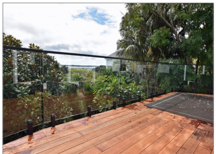
Juralco Edgetec Mini Post Framless Balustrade Face Fix to Timber Deck
